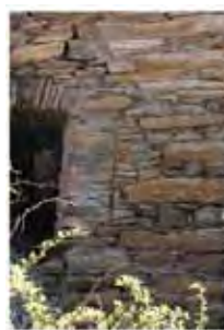
Figura 3.1.1: La differenza tra le pietre d'angolo gli elementi lapidei sul resto del muro.
