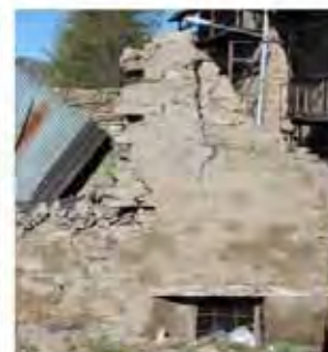
Figura 3.1.6: Intervento di calce per la finitura esterna della parete.
