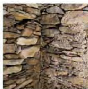
Figura 3.1.2: L'elemento protettivo della scala nel muro più antico (a sinistra) e presenza importante dell'alternanza nella parte recente (a destra).
